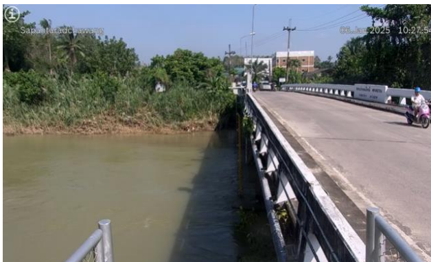
TC191001 : สะพานข้ามแม่น้ำตาปี ตลาดฉวาง ต.ฉวาง อ.ฉวาง จ.นครศรีธรรมราช
